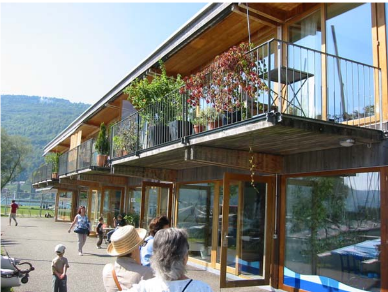
Barkenhafen Nidau, Pavillon Nord
